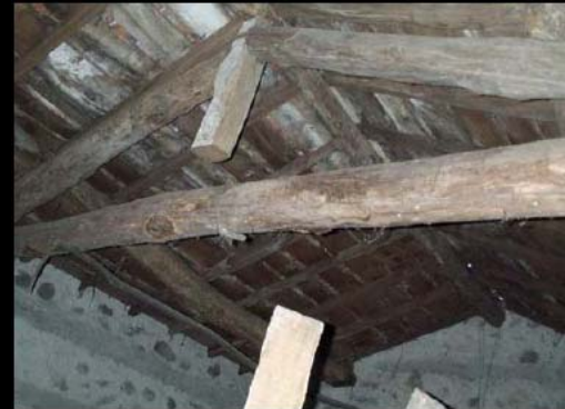
Copertura in legno non spingente con capriata.
