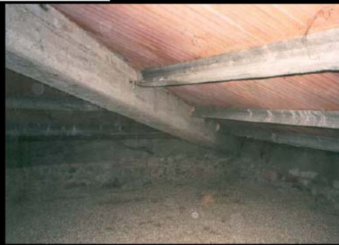
Copertura a padiglione con puntoni diagonali spingenti in cls.
