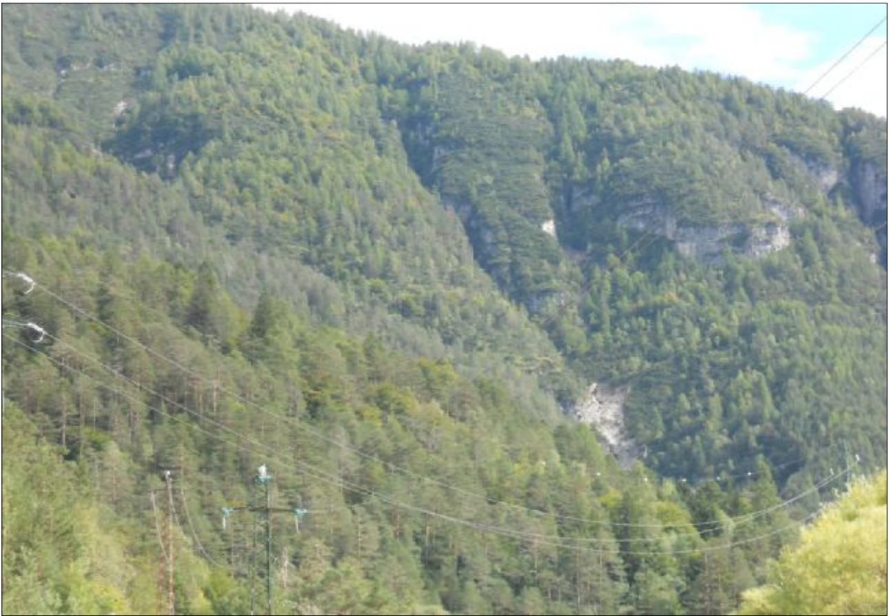
FOTO 3.11 – S.P. 251. LE LINEE ELETTRICHE POSSONO RAPPRESENTARE UNA POSSIBILE CAUSA D'INNESCO DEGLI INCENDI SOPRATTUTTO QUANDO ATTRAVERSANO TIPI FORESTALI AD ELEVATA POTENZIALITÀ PIROLOGICA
