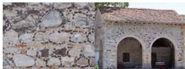
Murature in ciottoli del Piave in opera con la tipica lavorazione di Vidor (foto dell'autore)
