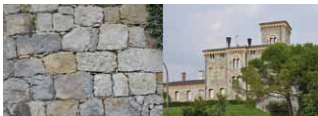
Materiale marnaceo impiegato nel cosiddetto "Castellet" di Tarzo (foto dell'autore)
