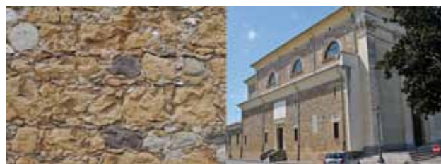
Materiale lapideo arenaceo impiegato nella parrocchiale di Bigolino (foto dell'autore)
