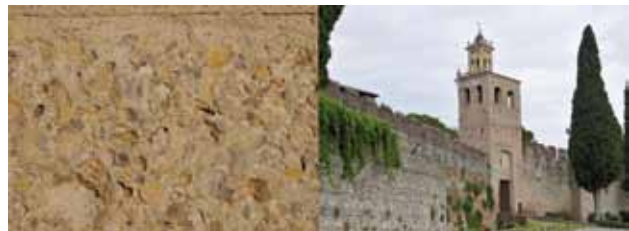
Materiale conglomeratico impiegato nelle mura del castello di S. Salvatore di Susegana (foto dell'autore)
