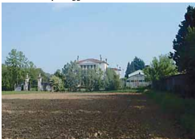
Villa Cornaro a Piambino Dese: il contesto figurativo è compromesso dagli interventi fuori dell'area vincolata
