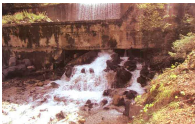
Fondazione della contro briglia da ripristinare in Comune di Selva di Cadore
