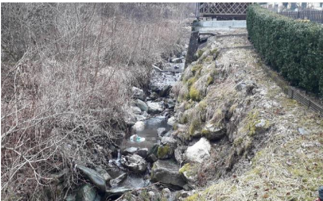
Zona dove è prevista la realizzazione del muro d'argine in c.l.s.
