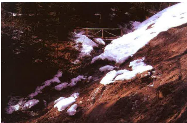
Tratto di opere in legname e pietrame da ripulire in Comune di Colle Santa Lucia
