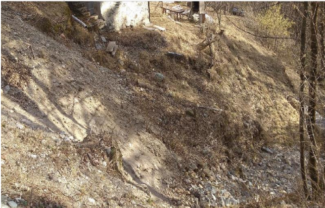
Zona dove è prevista l'opera di sostegno del versante in gabbioni metallici in località Stuer
