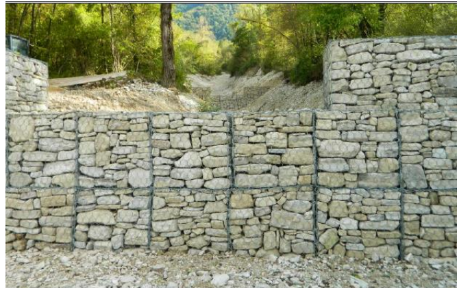
Esempio di opera di sostegno versante in gabbioni metallici
