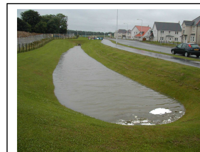
Figura 13: bacino di detenzione
