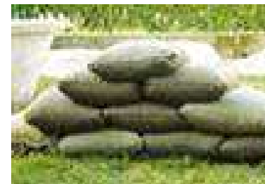
"Muretto" realizzato con sacchi - da Stoppingwater
