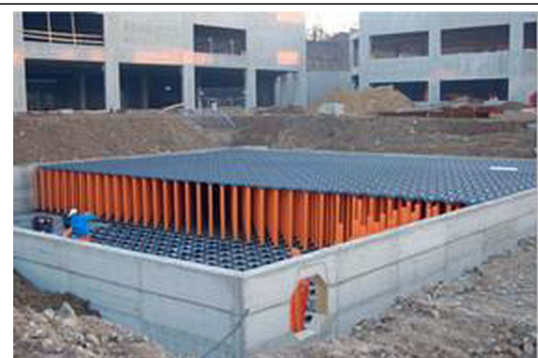
Figura 23 vasca in calcestruzzo in fase di costruzione
