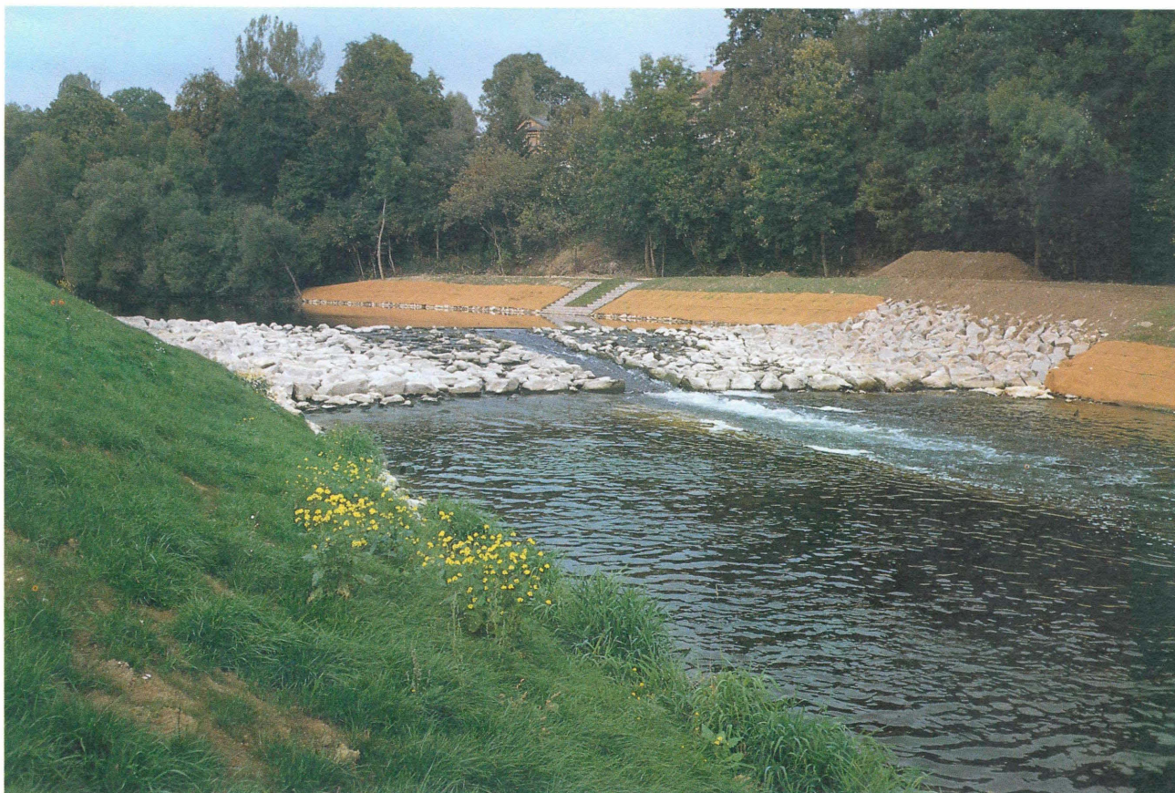
TAV. N. 43 Rampa in pietrame (in periodo di magra il deflusso idrico avviene attraverso il passaggio per canoe realizzato al centro dell'opera) (Fiume Danubio) Tipologia n. 26 a5
