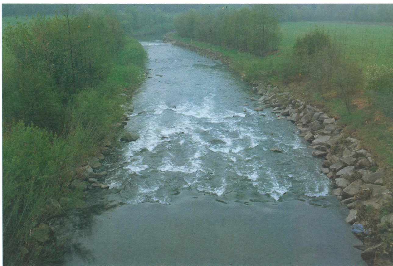
TAV. N. 36 Rampa in pietrame: consolidamento delle sponde con posa in opera di pietrame e piantagione di salici (il pietrame  stato collocato in modo irregolare per diversificare la morfologia dell'alveo) (Fiume Murr) Tipologia n. 26 a2
