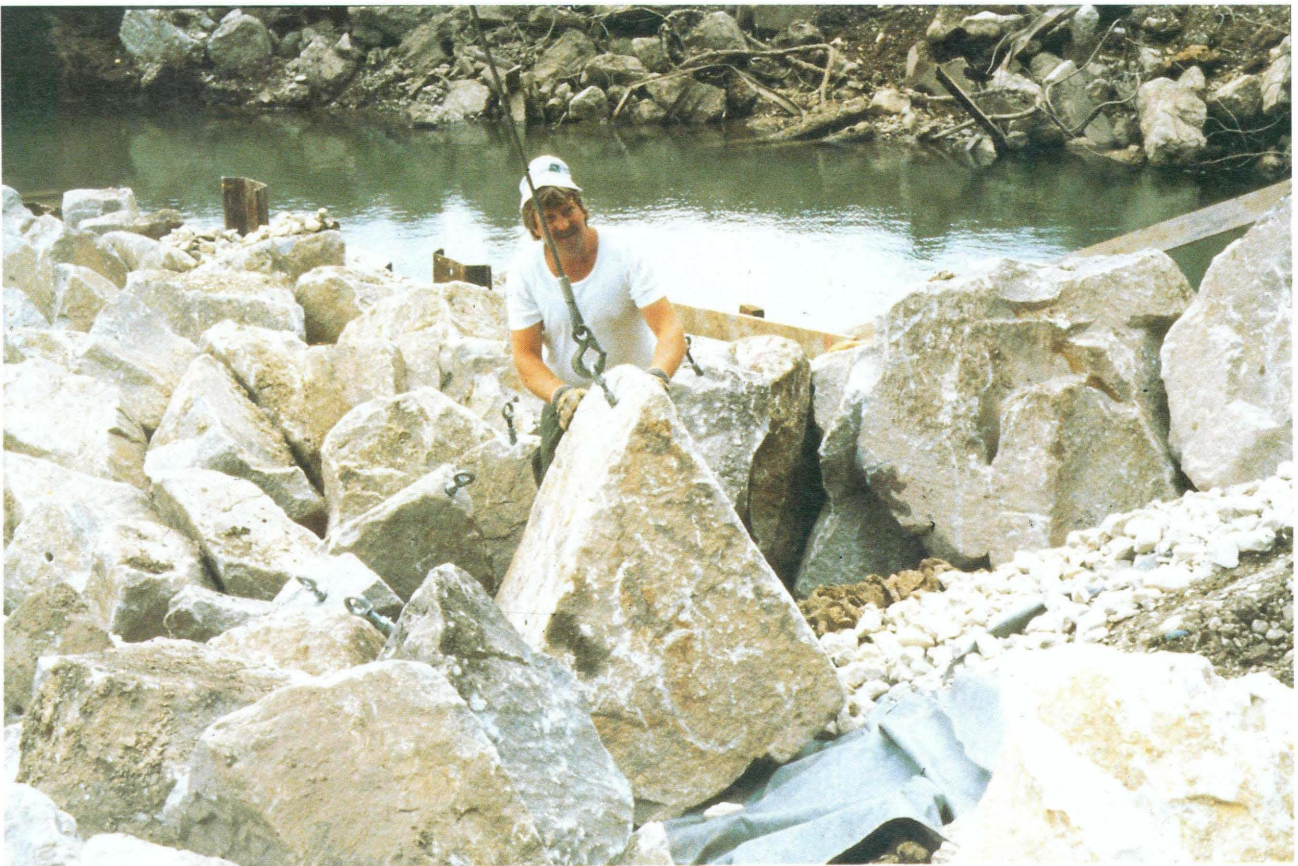
TAV. N. 42 Rampa in pietrame (posa in opera di massi ciclopici) (Fiume Danubio) Tipologia n. 26 a5
