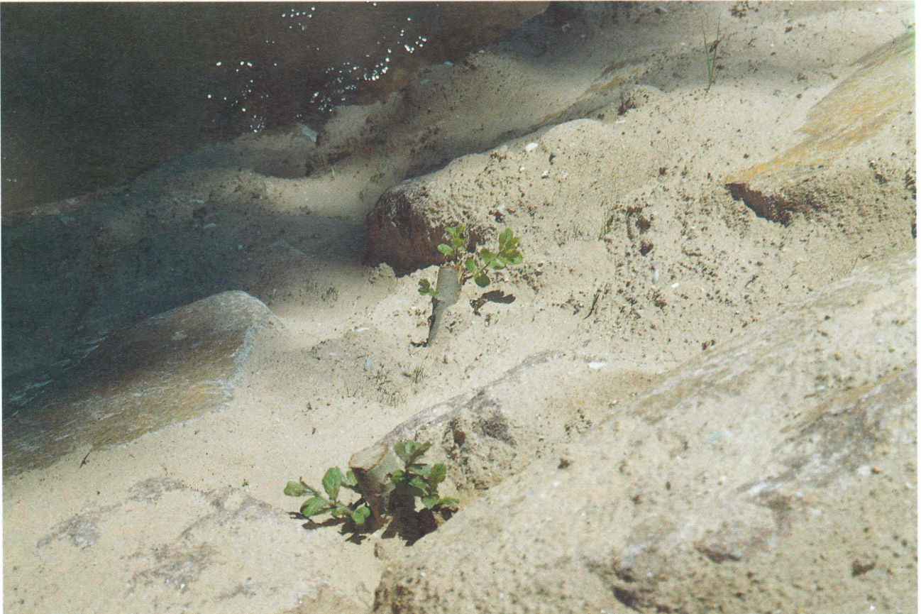
TAV. N. 1 Messa a dimora di talee in una difesa spondale (fase di realizzazione) (Val d'Adige - Bz) Tipologia n. 3
