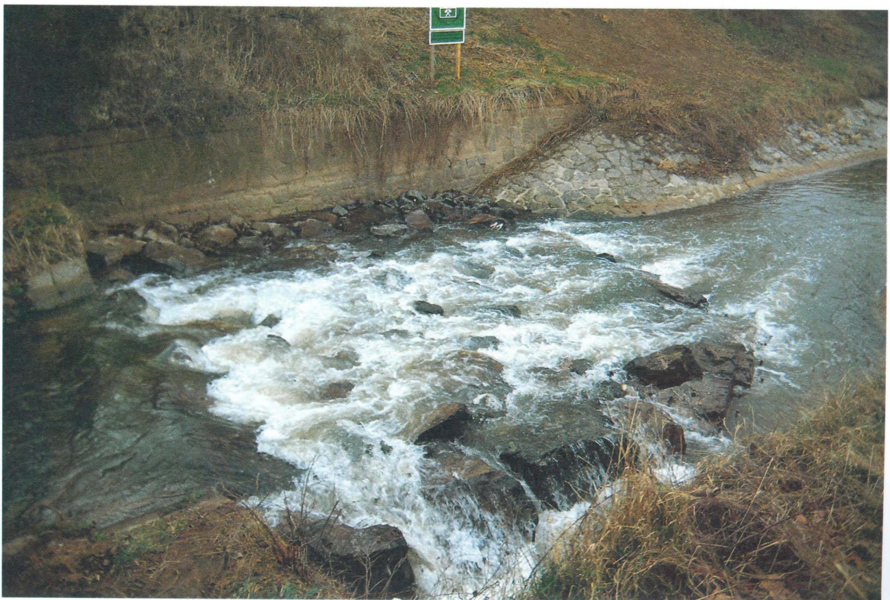
TAV. N. 40 Rampa in pietrame (realizzata collocando il pietrame a valle della briglia in calcestruzzo) (Fiume Pfrimm) Tipologia n. 26 a10
