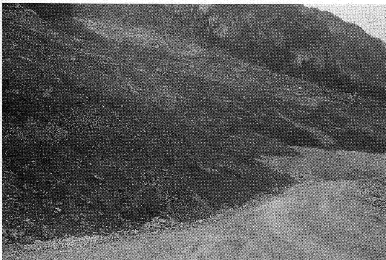
Foto n. 2 - Recupero ambientale di una ex-cava di versante con la tecnica del ripristino per lotti successivi (Innsbruck)
