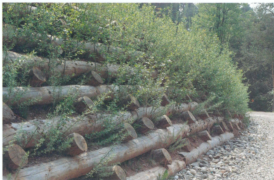
TAV. N. 16 Palificata in legname con messa a dimora di piantine (dopo 2 anni) (Frana Widmayr, San Genesio - Bz) Tipologia n. 14
