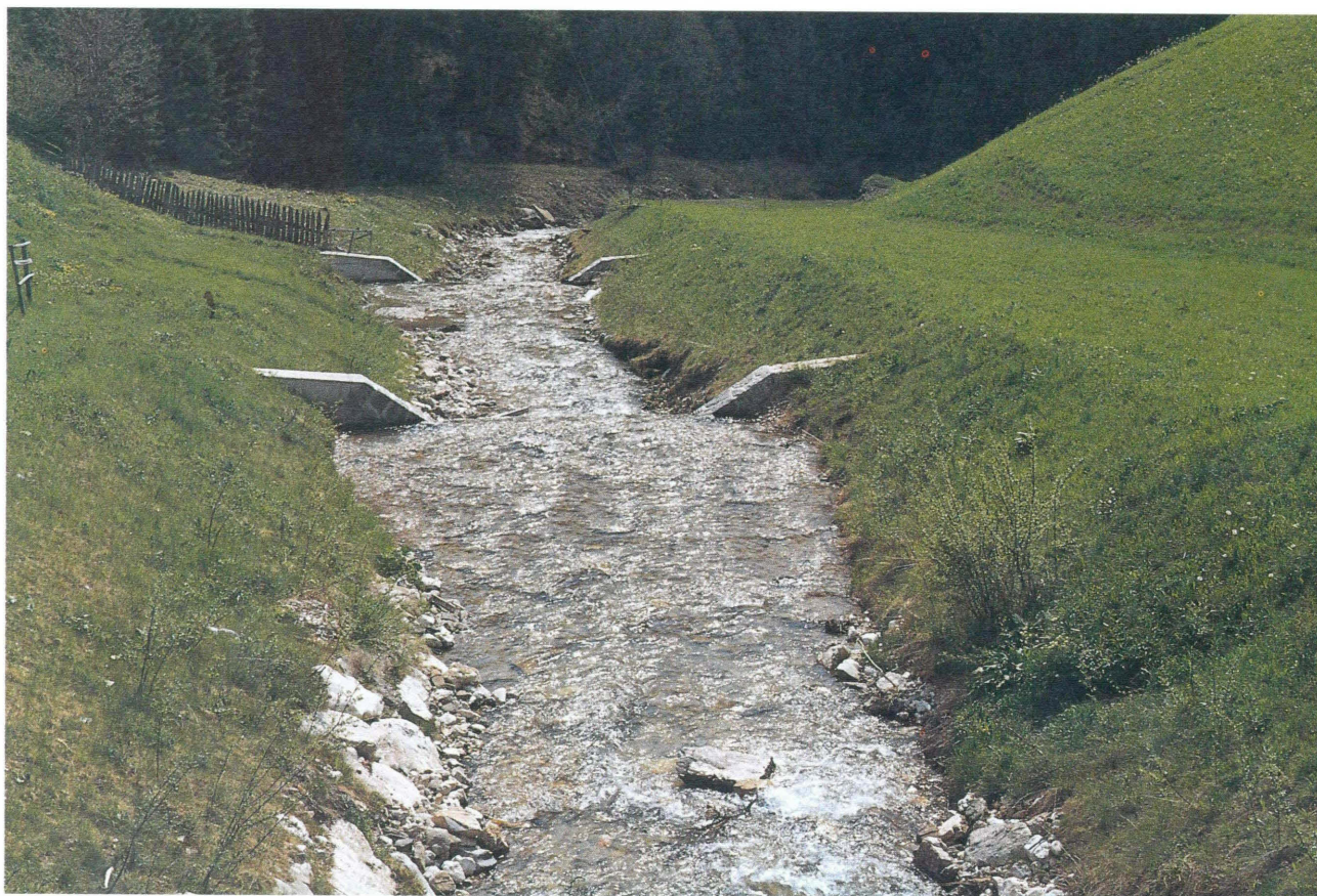
TAV. N. 4 Messa a dimora di specie arbustive o arboree lungo una sponda fluviale (situazione prima dell'intervento) (Rio Ciamplo, Val Badia - Bz) Tipologia n. 2
