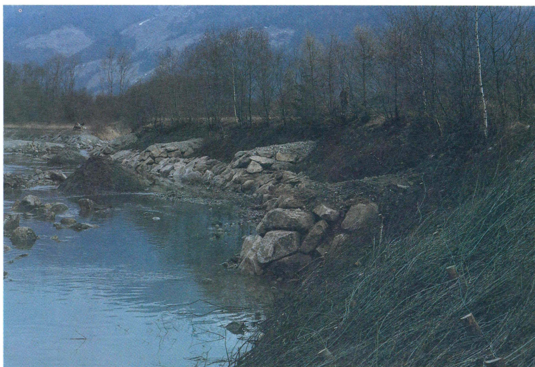
TAV. N. 30 Copertura diffusa con astoni di salice (fase di realizzazione) (Rio Aurino, Val Pusteria - Bz) Tipologia n. 20
