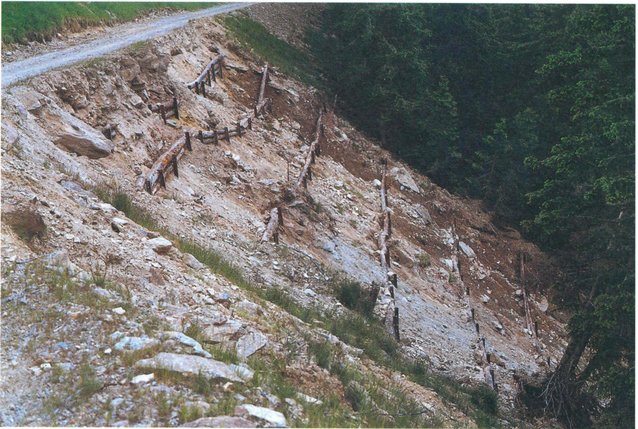
TAV. N. 21 Palizzata in legname ed inerbimento con coltre protettiva di paglia e bitume (fase di realizzazione) (Val d'Ultimo - Bz) Tipologie n. 1 e 13
