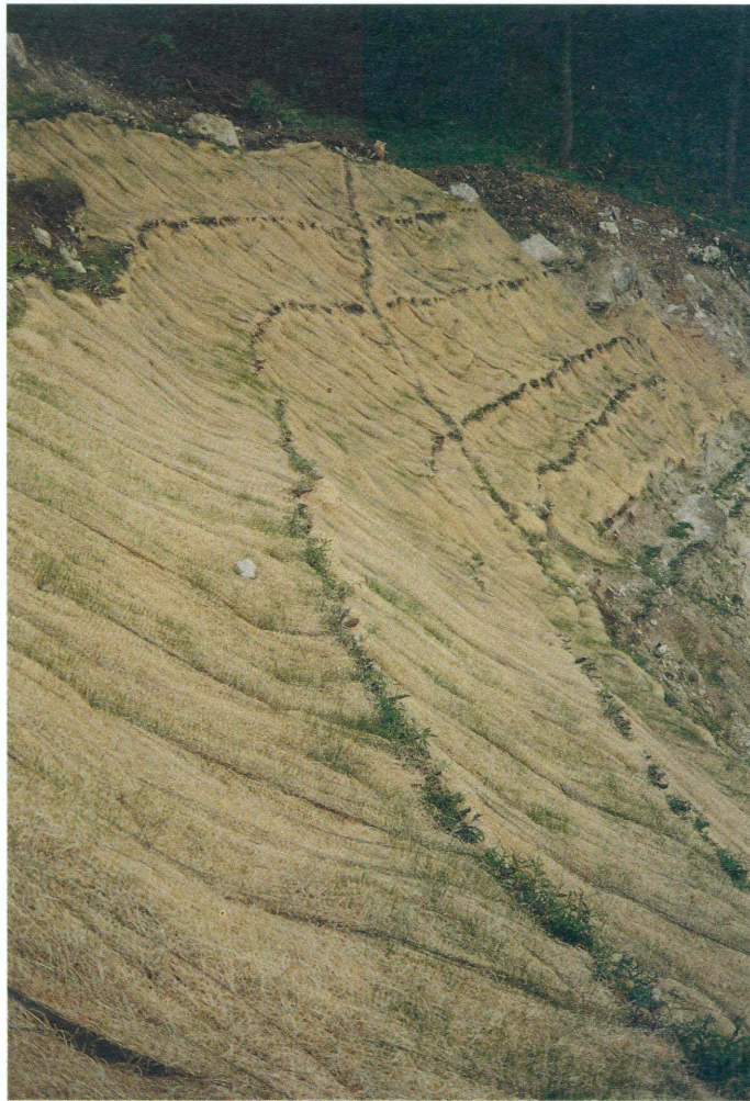
TAV. N. 25 Sistemazione con reti o stuoie in fibra naturale ed inerbimento (Frana Masarè, Agordino - Bl) Tipologia n. 18
