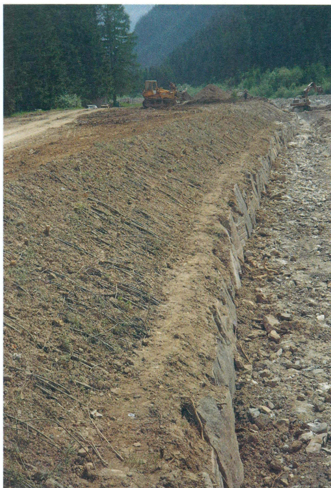
TAV. N. 29 Copertura diffusa con astoni di salice (fase di realizzazione) (Torrente Biois, Agordino - Bl) Tipologia n. 20
