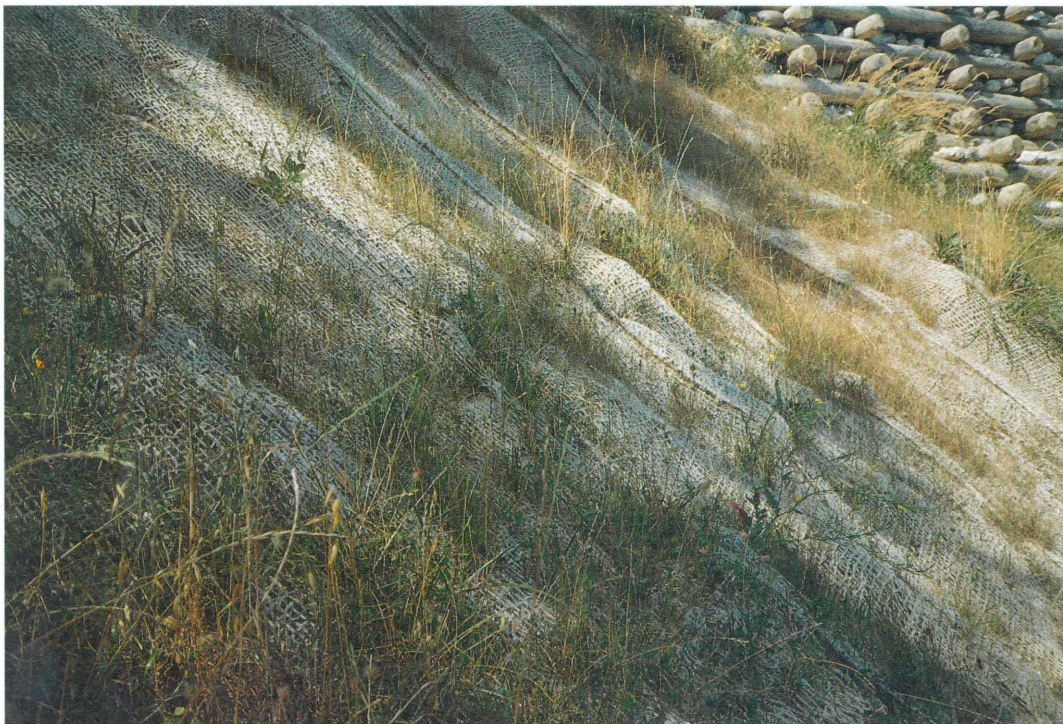
TAV. N. 26 Sistemazione con reti o stuoie in fibra naturale ed inerbimento (Frana Cima Gogna, Cadore - Bl) Tipologia n. 18
