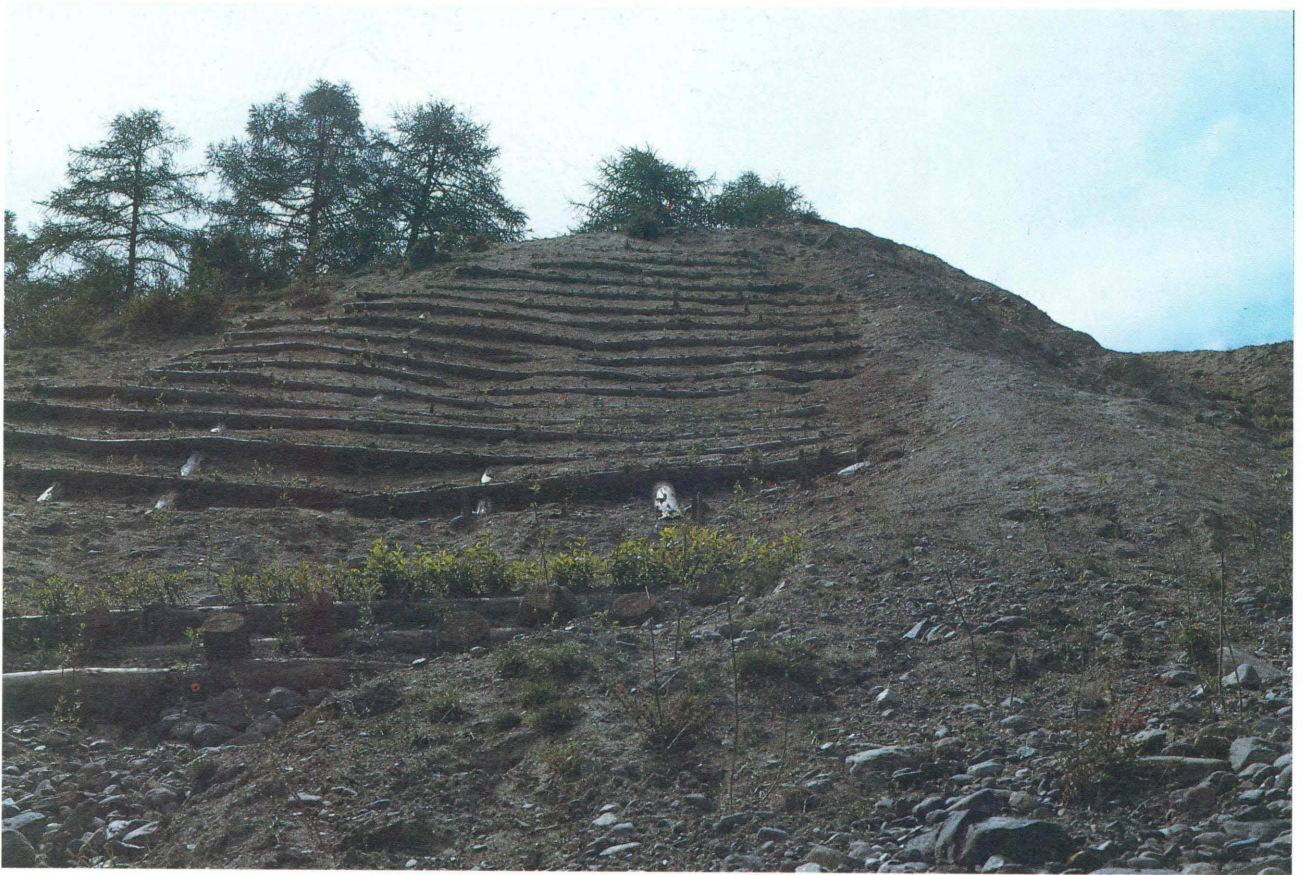
TAV. N. 17 Grata in legname con talee e piantine (fase di realizzazione) (Frana San Martino, Lasa - Bz) Tipologia n. 12
