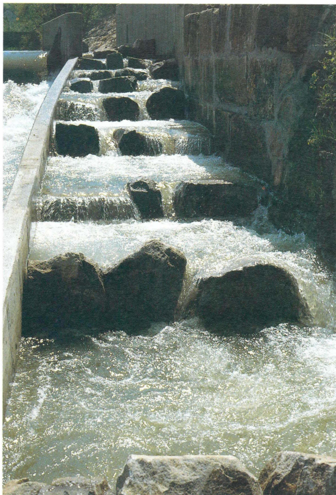
TAV. N. 47 Rampa in pietrame (passaggio per pesci a bacini successivi - con deflusso idrico) (Fiume Fils) Tipologia n. 26 b4
