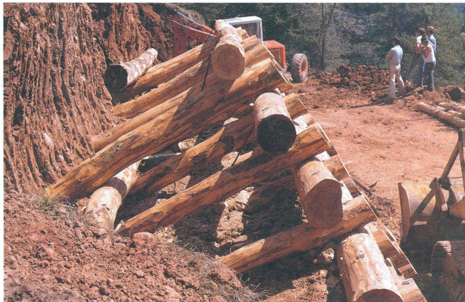
TAV. N. 15 Palificata in legname con messa a dimora di piantine (dopo 5 mesi) (Frana Widmayr, San Genesio - Bz) Tipologia n. 14
