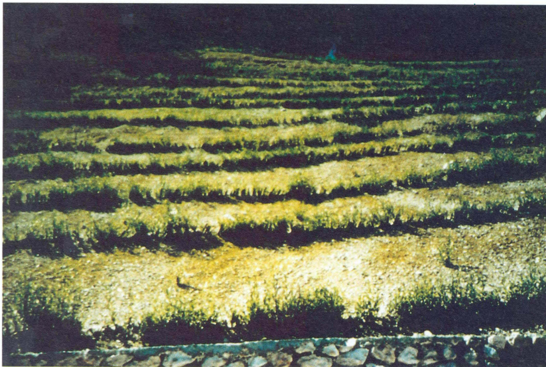
TAV. N. 13 Gradonata con talee (Frana nel T. Rù Secco, Val del Boite - Bl) Tipologia n. 4
