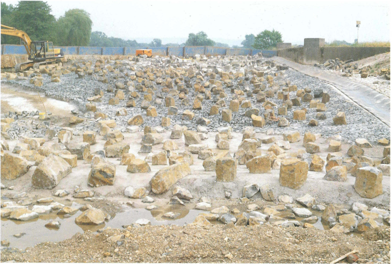
TAV. N. 45 Rampa in pietrame (fase di realizzazione) (Fiume Sieg) Tipologia n. 26 a
