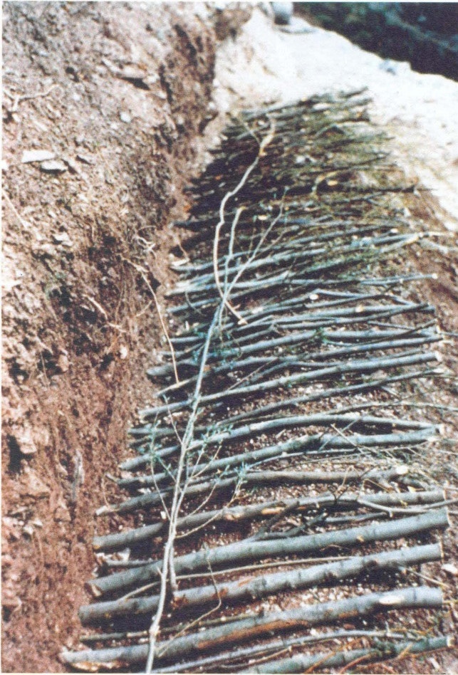
TAV. N. 11 Gradonata con talee (fase di realizzazione) (Frana nel T. Rù Secco Val del Boite - Bl)
