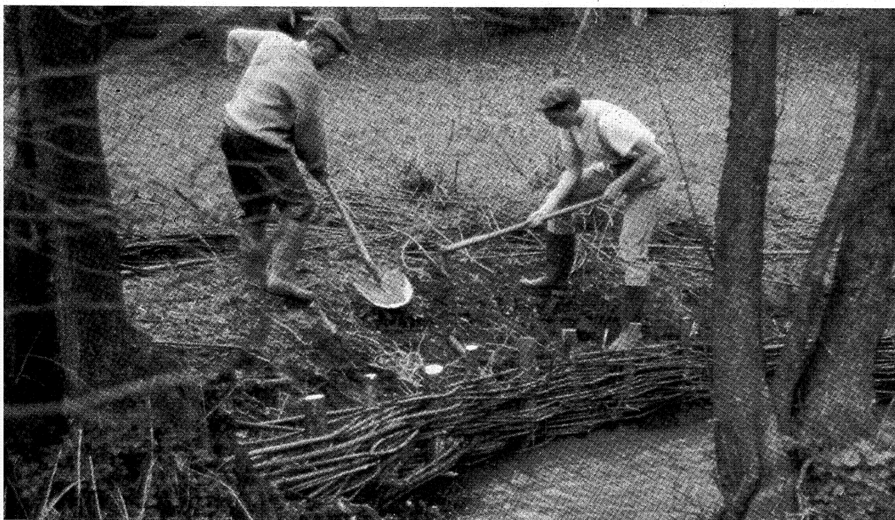
Foto n. 11 - Consolidamento di un ruscello attraverso l'impiego di talee e picchetti di legno (nelle tecniche di ingegneria naturalistica il costo dell'intervento è legato soprattutto a quello della manodopera)
