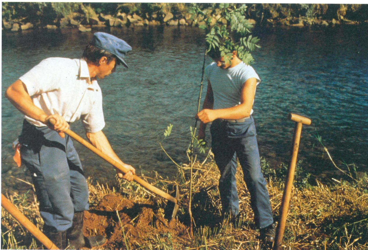
TAV. N. 3 Messa a dimora di specie arbustive o arboree lungo una sponda fluviale (fase di realizzazione) Tipologia n. 2
