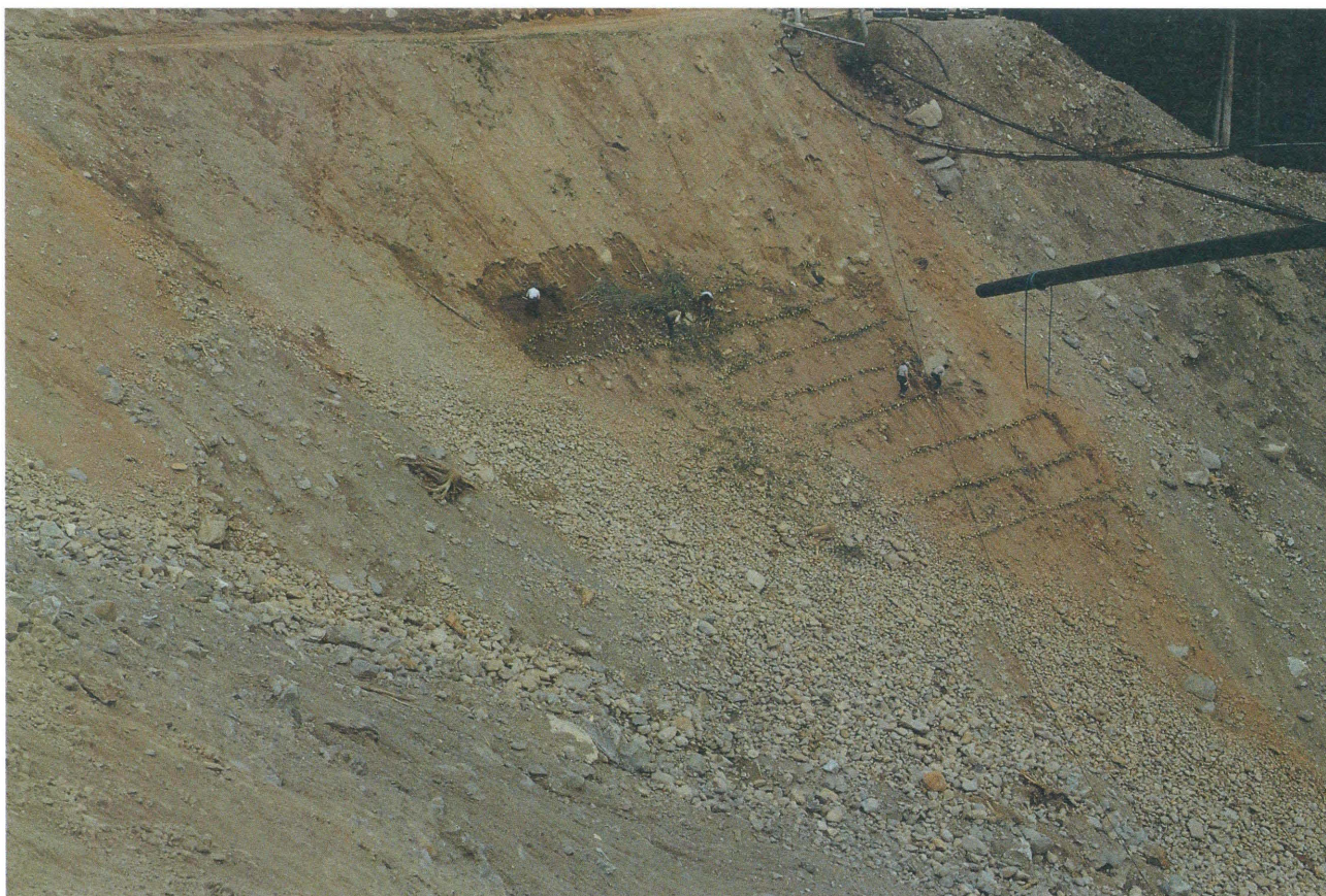
TAV. N. 7 Gradonata con talee (fase di realizzazione) (Frana Prünster - Bz) Tipologia n. 4
