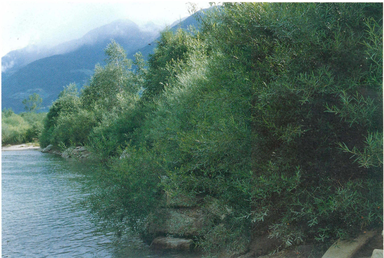
TAV. N. 32 Copertura diffusa con astoni di salice (dopo 5 anni) (Rio Aurino, Val Pusteria - Bz) Tipologia n. 20
