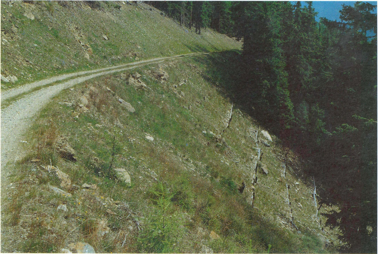
TAV. N. 23 Palizzata in legname ed inerbimento con coltre protettiva di paglia e bitume (dopo 8 anni) (Val d'Ultimo - Bz) Tipologie n. 1 e 13
