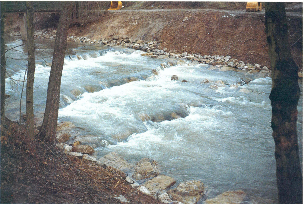
TAV. N. 34 Rampa in pietrame (realizzata eliminando la soglia in calcestruzzo e collocando il pietrame in modo da diversificare la morfologia dell'alveo) (Fiume Odenwälder Elz) Tipologia n. 26 a8
