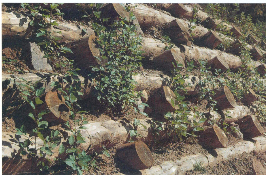
TAV. N. 16 Palificata in legname con messa a dimora di piantine (dopo 2 anni) (Frana Widmayr, San Genesio - Bz) Tipologia n. 14
