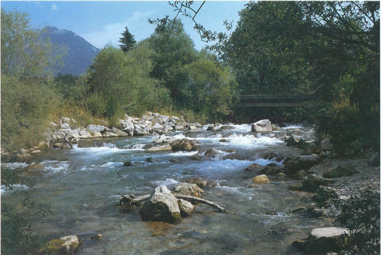
TAV. N. 37 Rampa in pietrame (realizzata eliminando la briglia in calcestruzzo al fine di diversificare la morfologia dell'alveo - vista da valle) (Fiume Leitzach) Tipologia n. 26 a9
